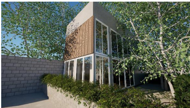
Obr. 29 Príklad využitia systému ako obkladu – tienenia (Kamenská, Kapiášová 2024)
